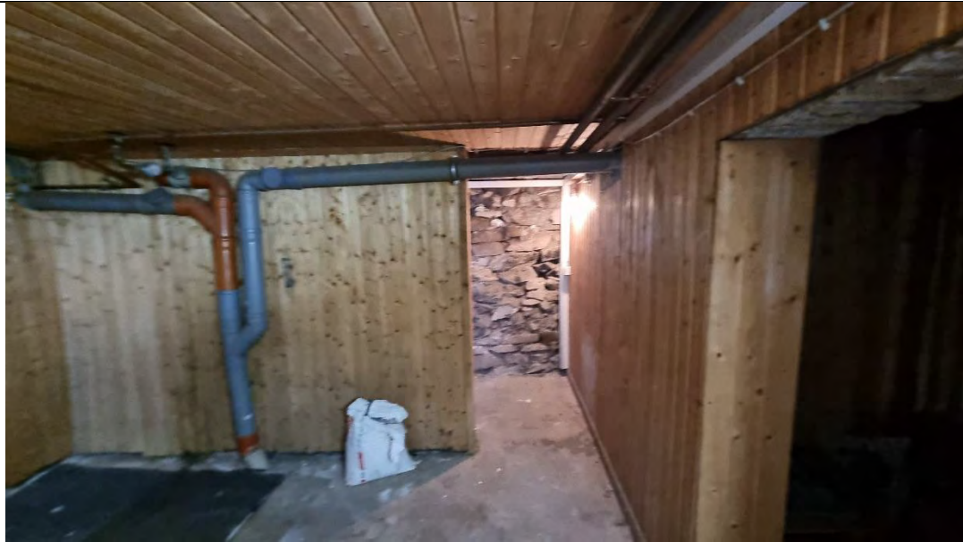
Zentraler Kellerraum –Durchgang zum neueren Kellerteil an der Ostseite
