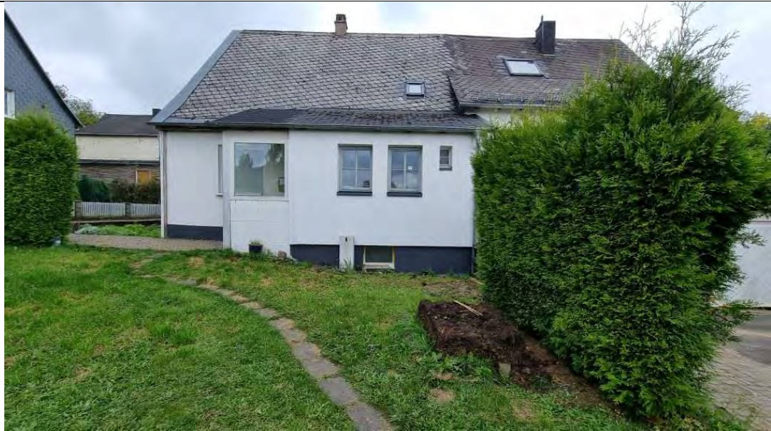
südlicher älterer Hausteil mit Anbau
