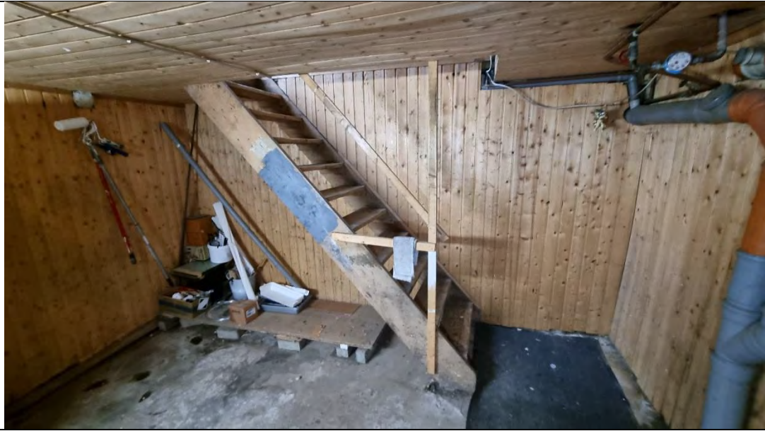
Kellertreppe - Blick nach Norden
