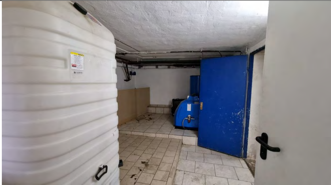
Heizungs- und Ölraum
