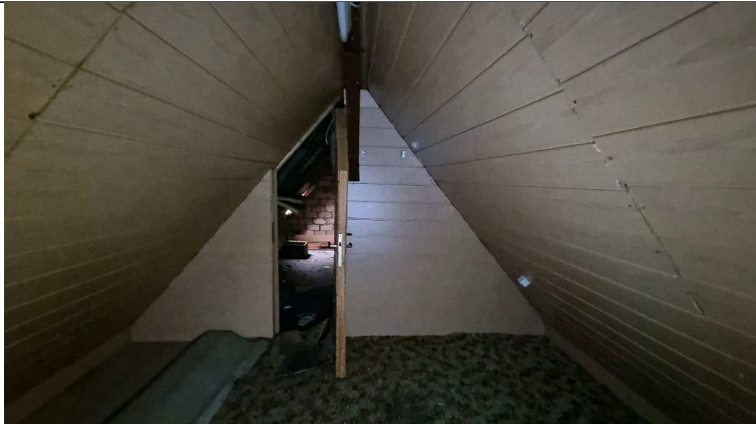
Dachkammer - Blick nach Norden
