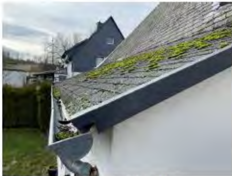
Dach über Hauseingang/Gäste-Bad
