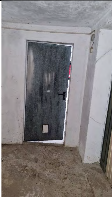
Garagenvorraum Südseite- Durchgang zum Keller
