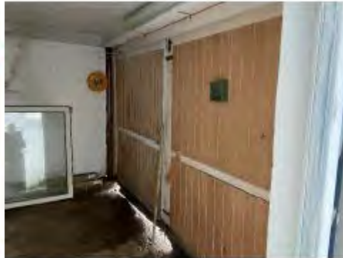
Garagenvortor nach außen, unterhalb der Terrasse, nur von innen zu öffnen
