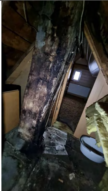
versotteter Schornstein ausser Betrieb
