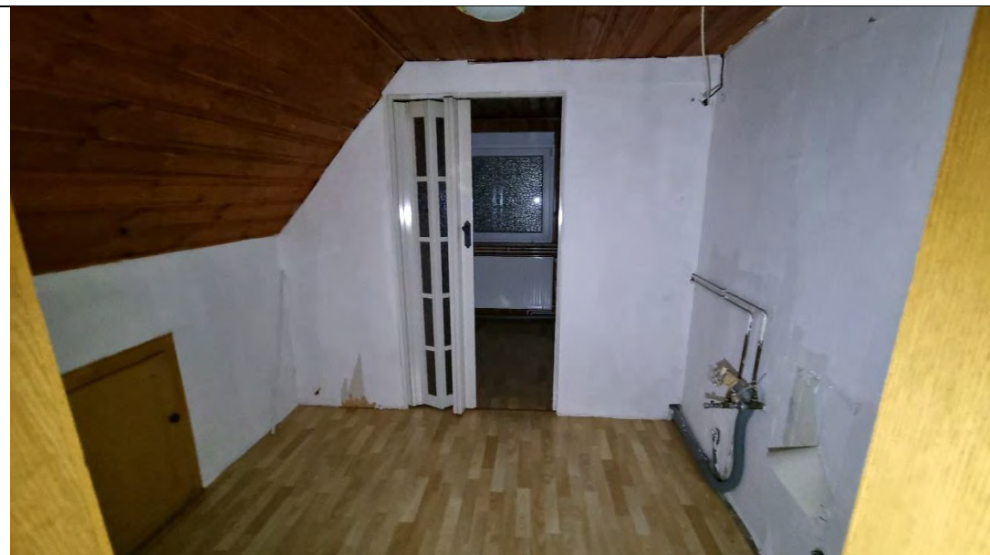
OG Ostseite ehem. Küche, dahinter Durchgang zum Bad
