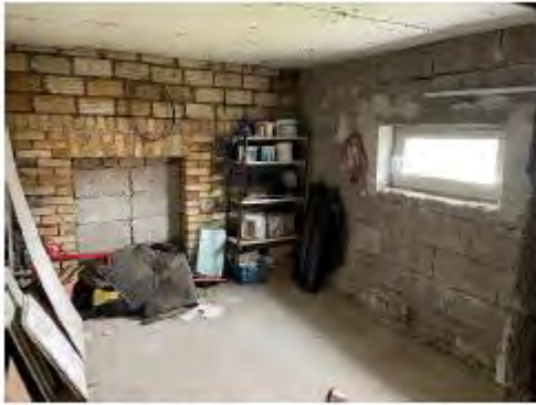
Kellerraum hinter Heizungsraum, Zugang über Garage
