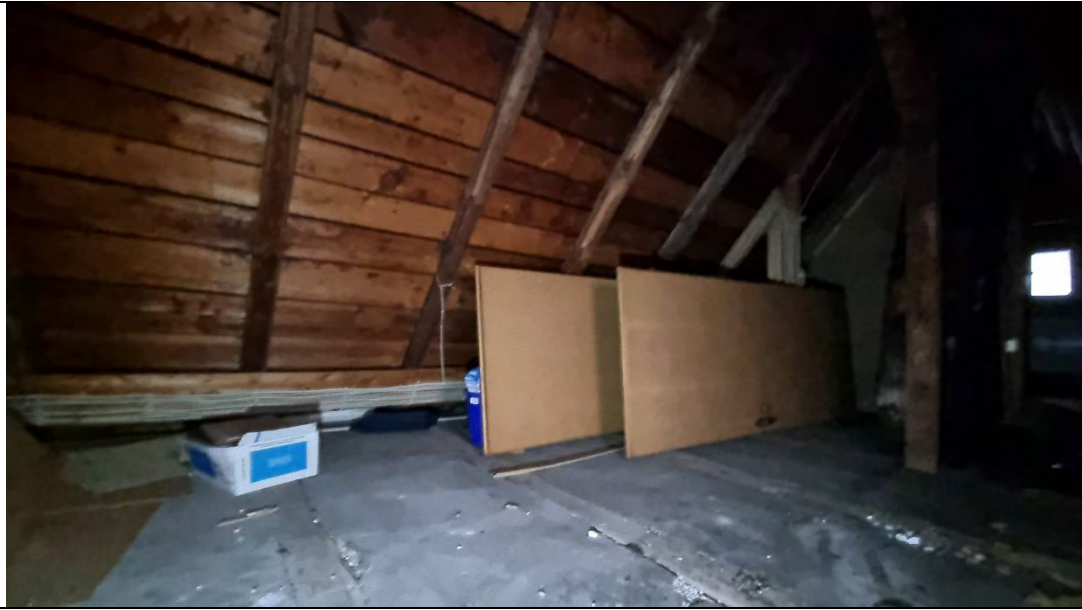
Dachboden alter Hausteil - Blick nach Süden
