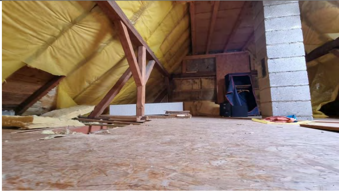
begonnener Ausbau Blick nach Norden
