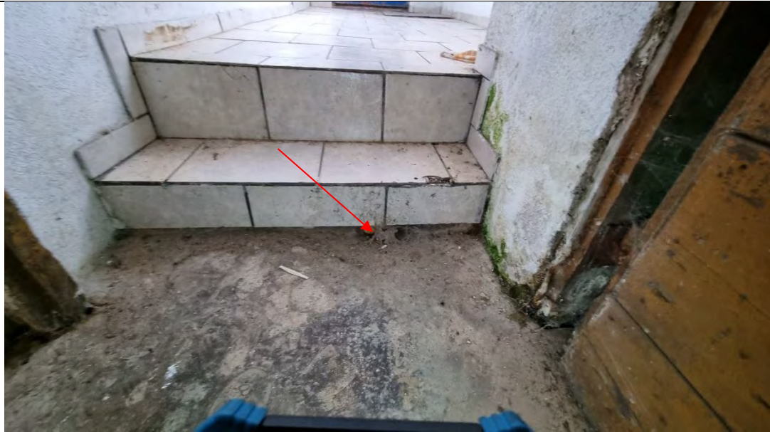
Einlauf in Zisterne ?
