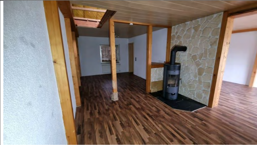
Deckendurchbruch als einziger Zugang zum Dachgeschoss im Hintergrund Eingang zum Bad- im Rohbau befindlich
