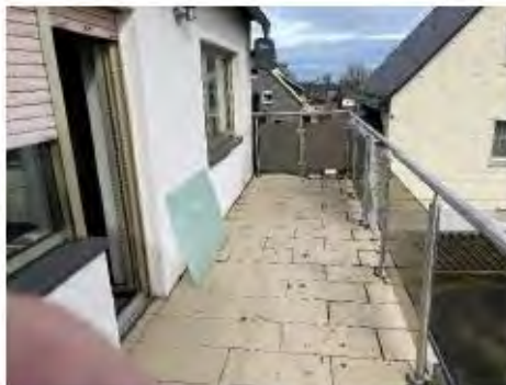
Terrasse vom Wohnzimmer begehbar
