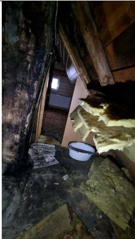
Durchgang zu Dachkammer
