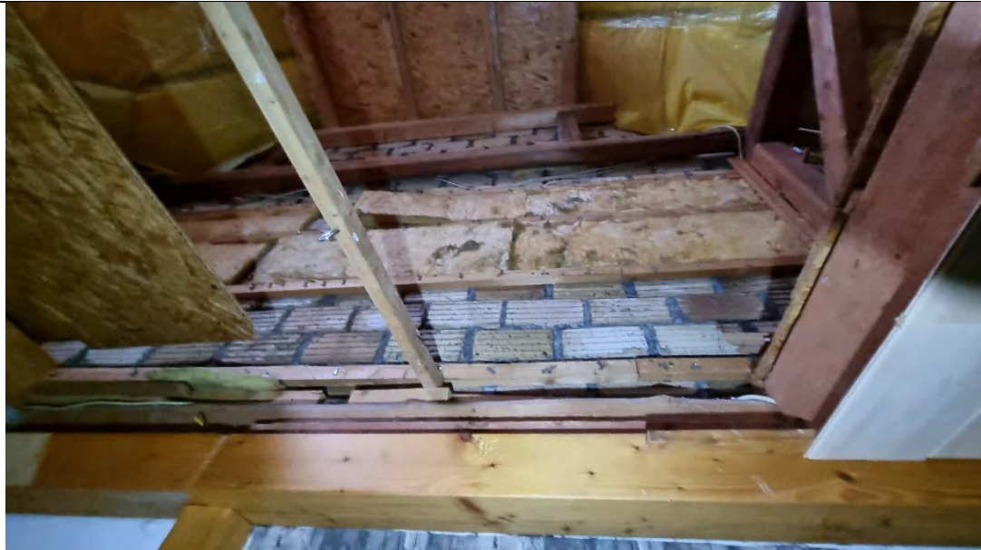
Trennwand zum alten Haus
