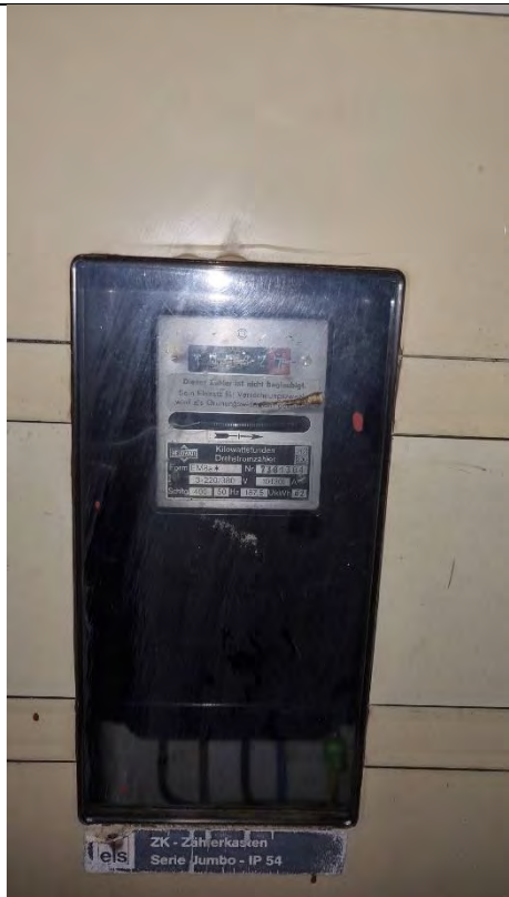
Zwischenzähler- nicht geeicht- in Zählerkasten Garage
