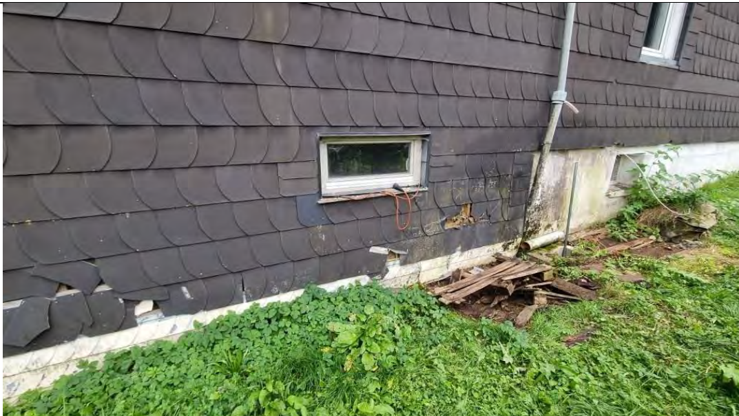
Fassade schadhaft
