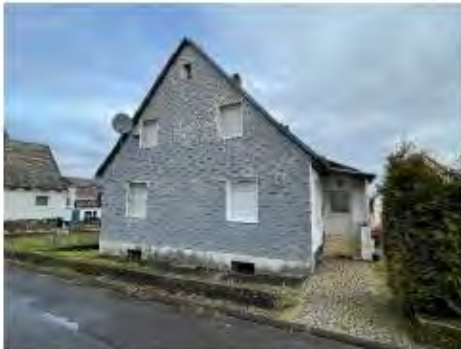
Südgiebel und überdachter Hauseingang
