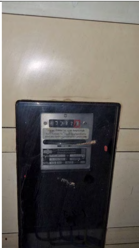
Zwischenzähler- nicht geeicht- in Zählerkasten Garage
