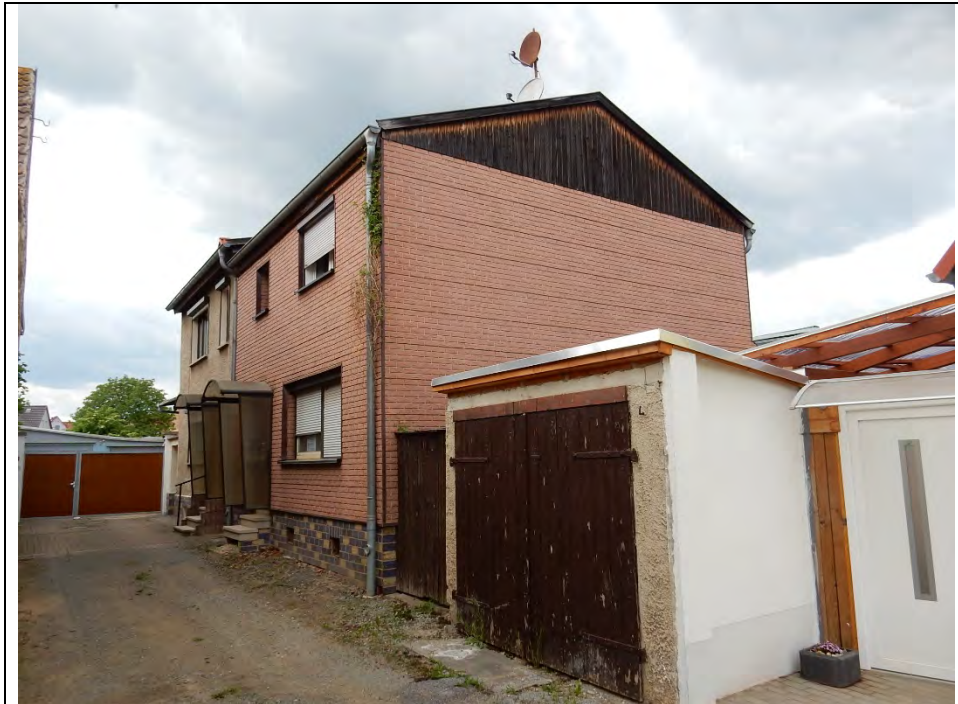
Blick auf die Liegenschaft – Lindenweg 13
