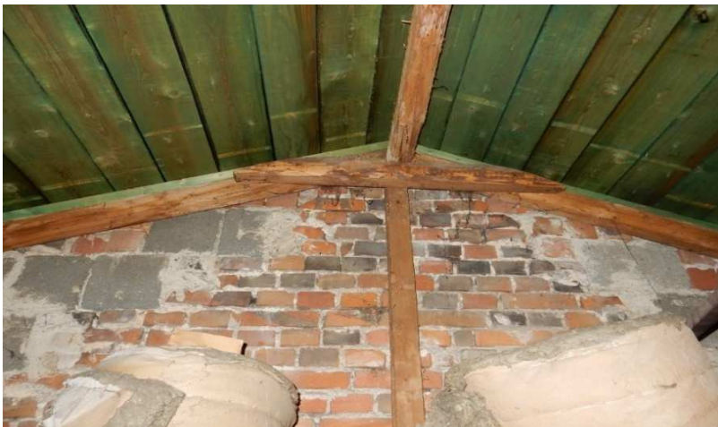
Giebel im Dachboden
