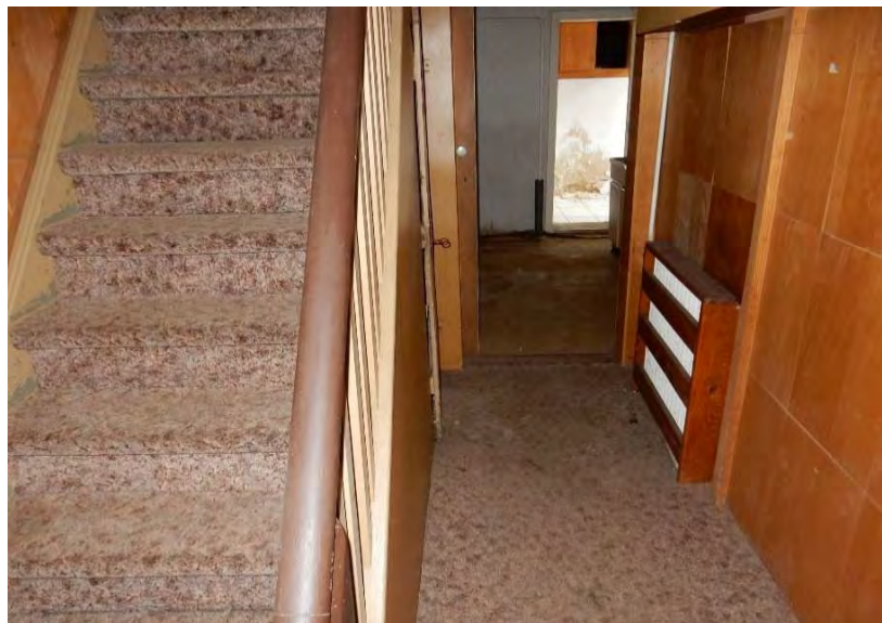
Flur, EG Geschosstreppe
