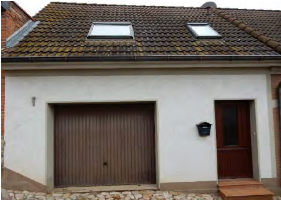
Zugang zum Nebengebäude mit separater Wohnung und Garage in der Kirchstraße die Wohnung im Nebengebäude liegt im Erdgeschoss des Nebengebäudes sowie im Obergeschoss und Dachgeschoss des Haupthauses
