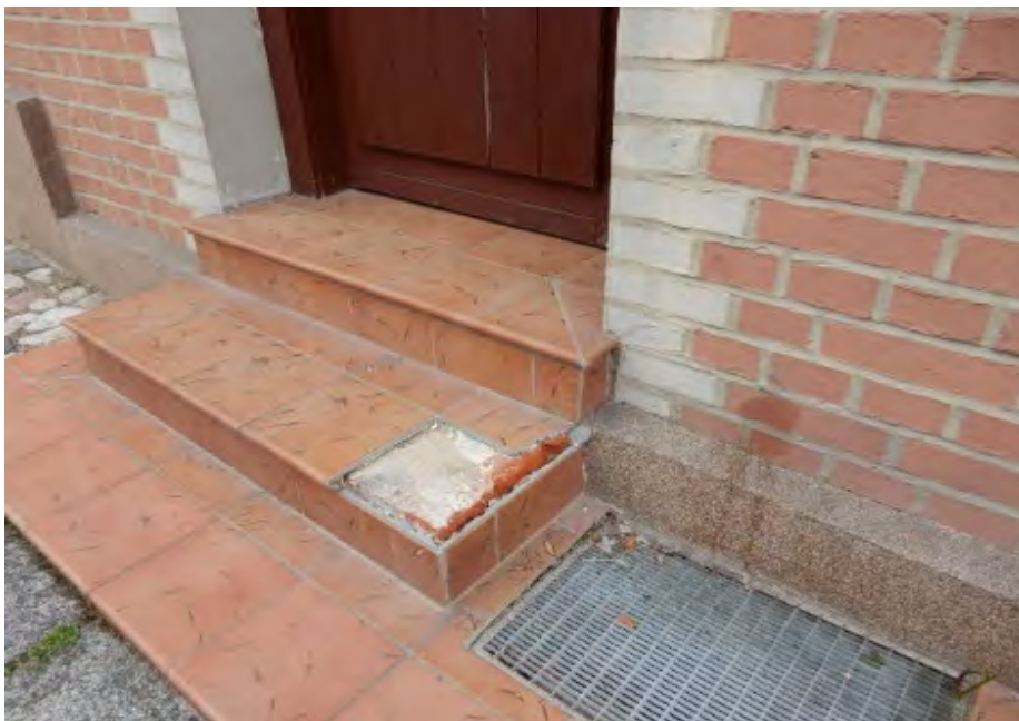
in den öffentlichen Straßenbereich errichtete Zugangstreppe
