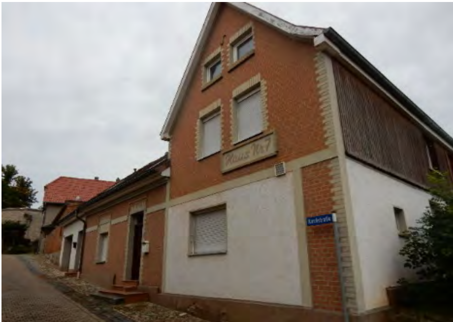
Ansicht des Vertragsobjektes von der Kreuzung Ringstraße / Kirchstraße
