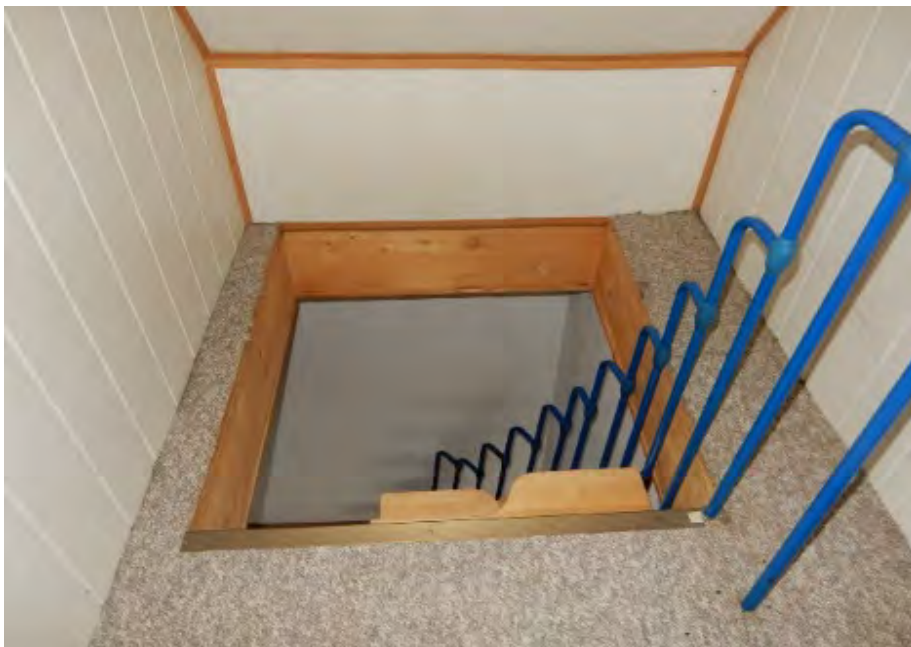
Treppe vom Dachgeschoss zum Obergeschoss Blick vom Dachgeschoss
