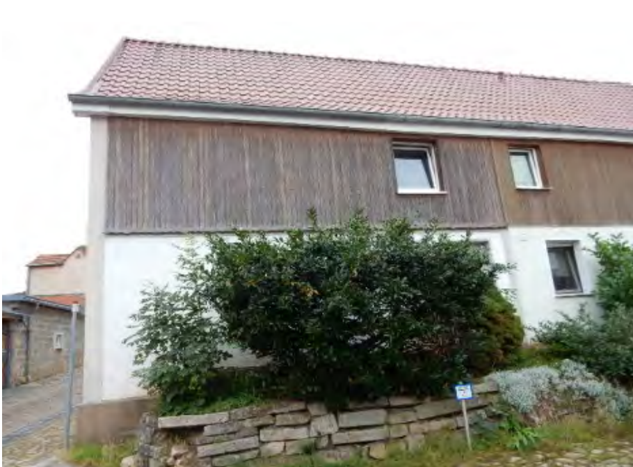
Ansicht von der Ringstraße
