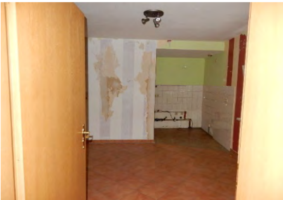
Küche im Erdgeschoss mit Fließenspiegel offener Wohn- Küchenbereich
