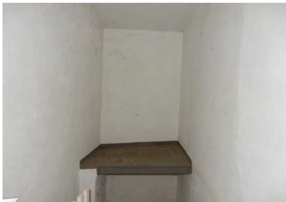
Bereich über dem Zugang zum Keller
