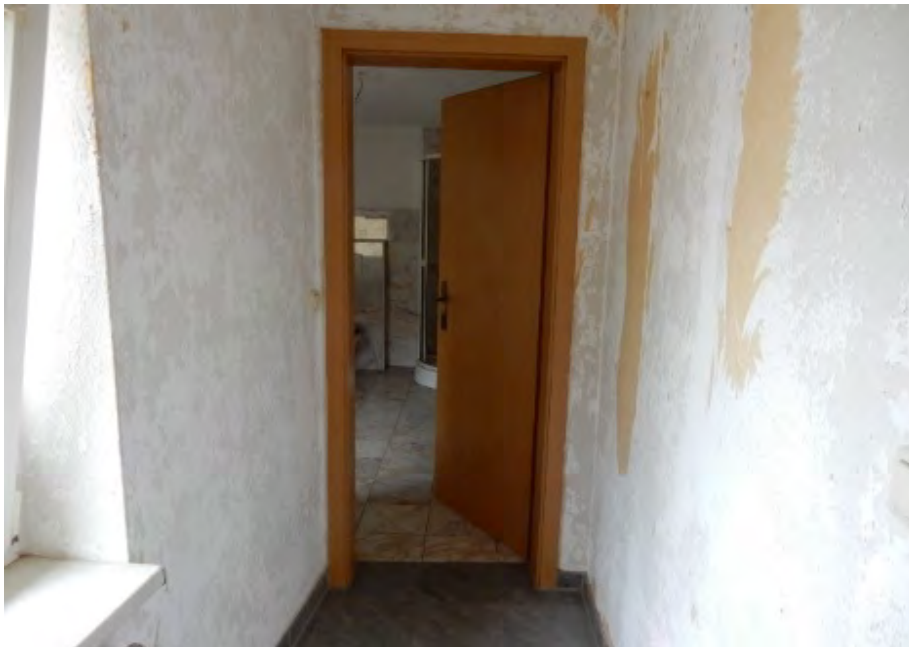
Badezimmer im Obergeschoss des Hauptgebäudes
