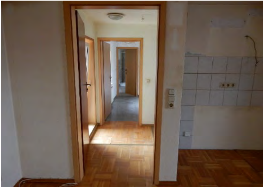
Flur vom Nebengebäude zum Hauptgebäude Blick Richtung Ringstraße
