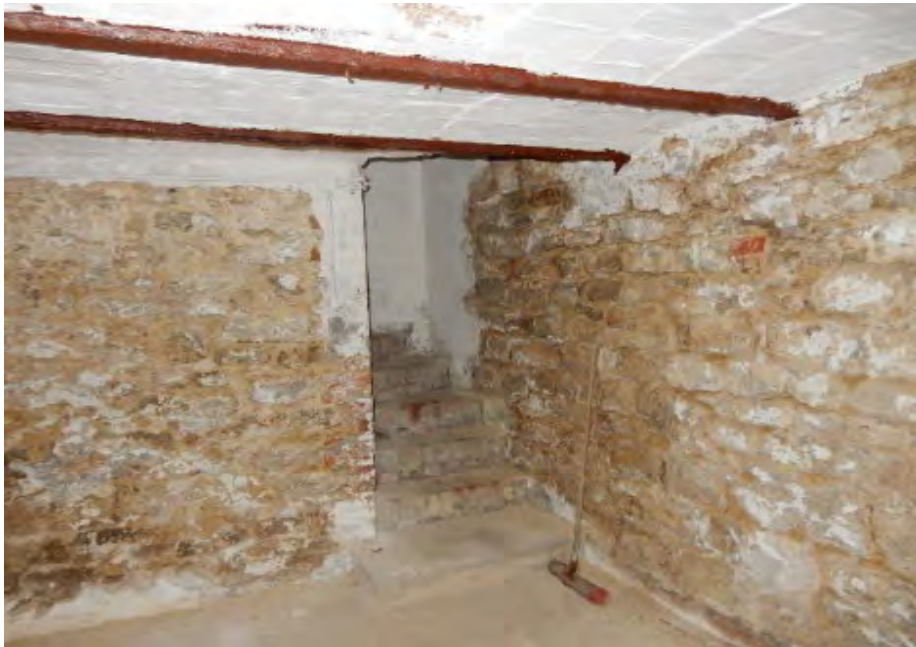
Blick Richtung Kellertreppe
