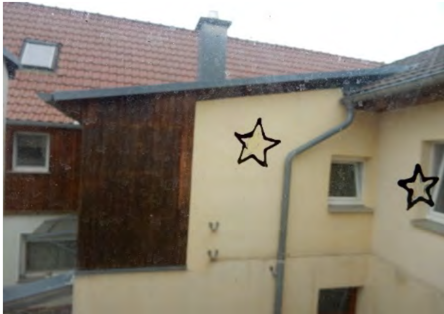
Blick vom Obergeschoss in den Hofraum
