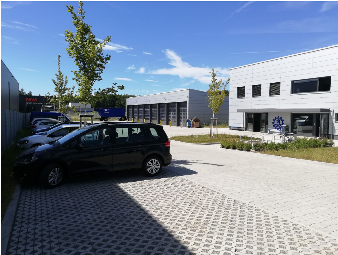
Abbildung 1: KFZ-Halle; Blick von Nordost nach Südwest (Quelle: Aufnahme BlmA)
