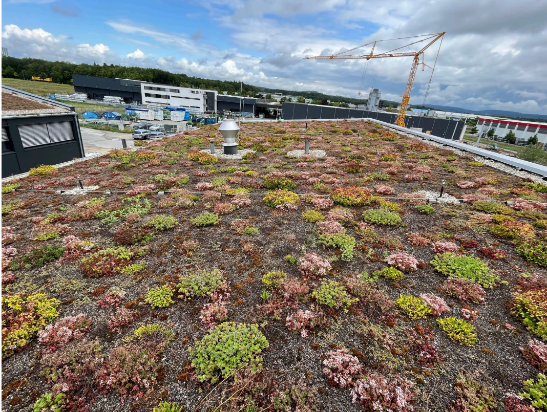
Abbildung 3: Dachdeckung, extensive Begrünung (Quelle: Aufnahme BlmA)
