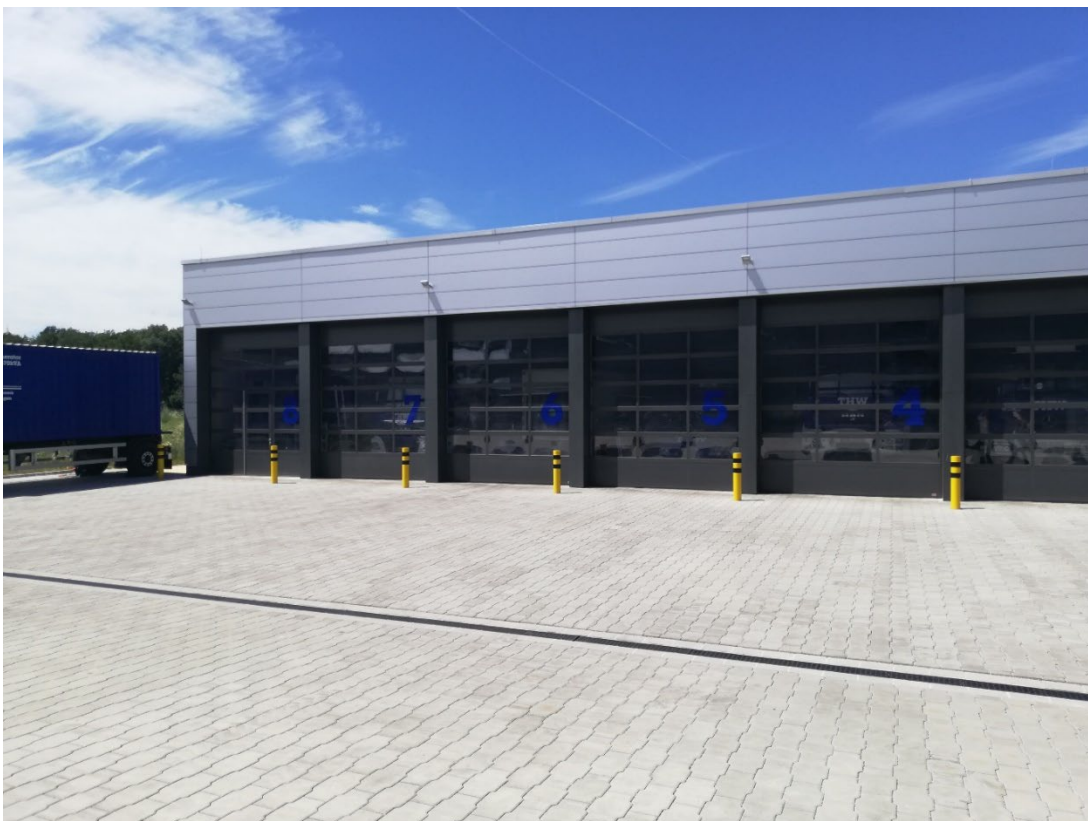
Abbildung 2: KFZ-Halle; Blick von Nordost nach Südwest (Quelle: Aufnahme BlmA)
