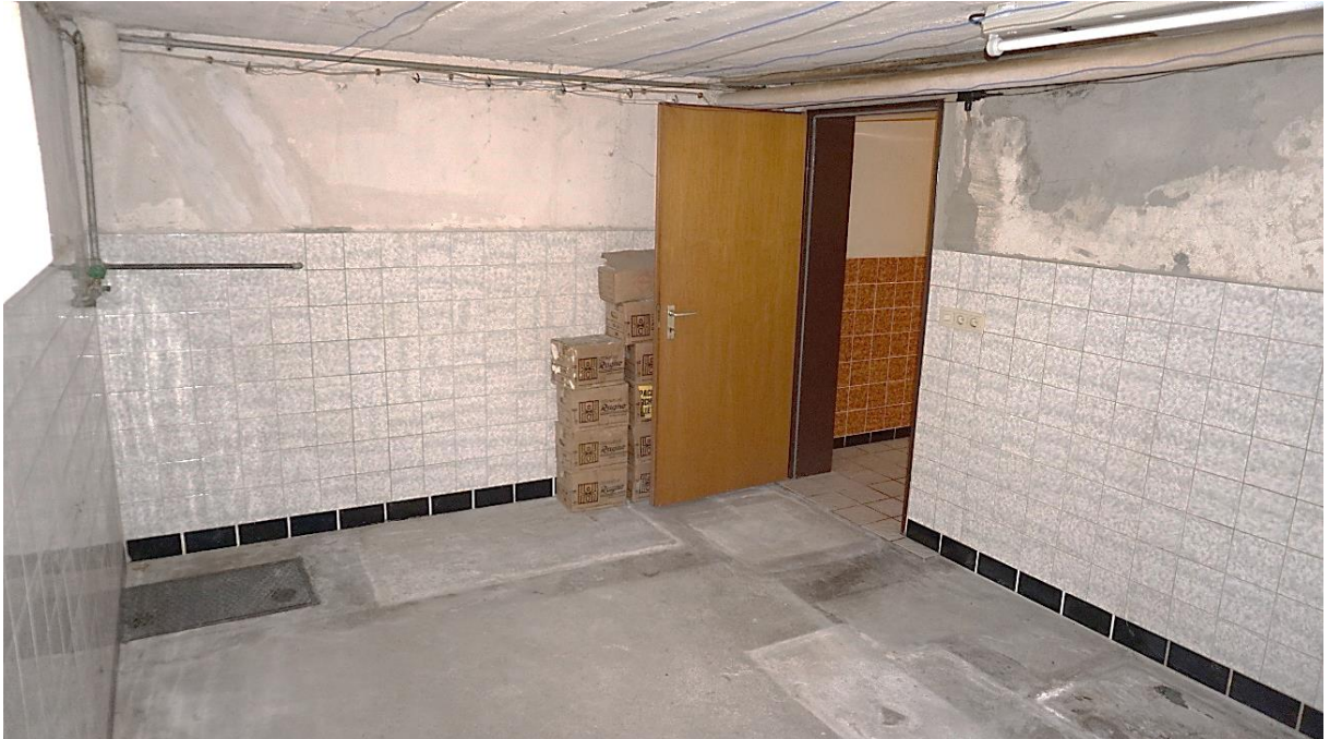
Waschküche mit Gartenausgang, Ansicht 02
