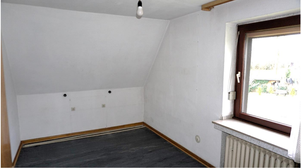
Kinderzimmer Obergeschoss, Ansicht 01
