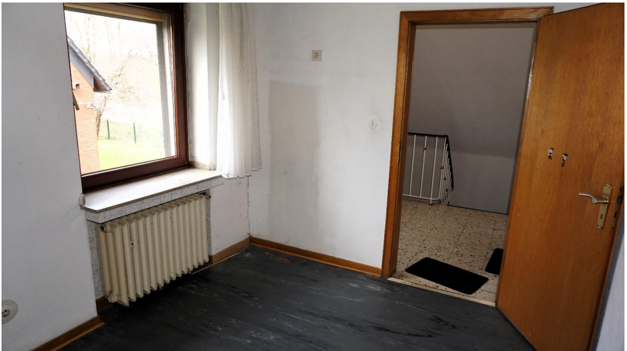
Kinderzimmer Obergeschoss, Ansicht 02
