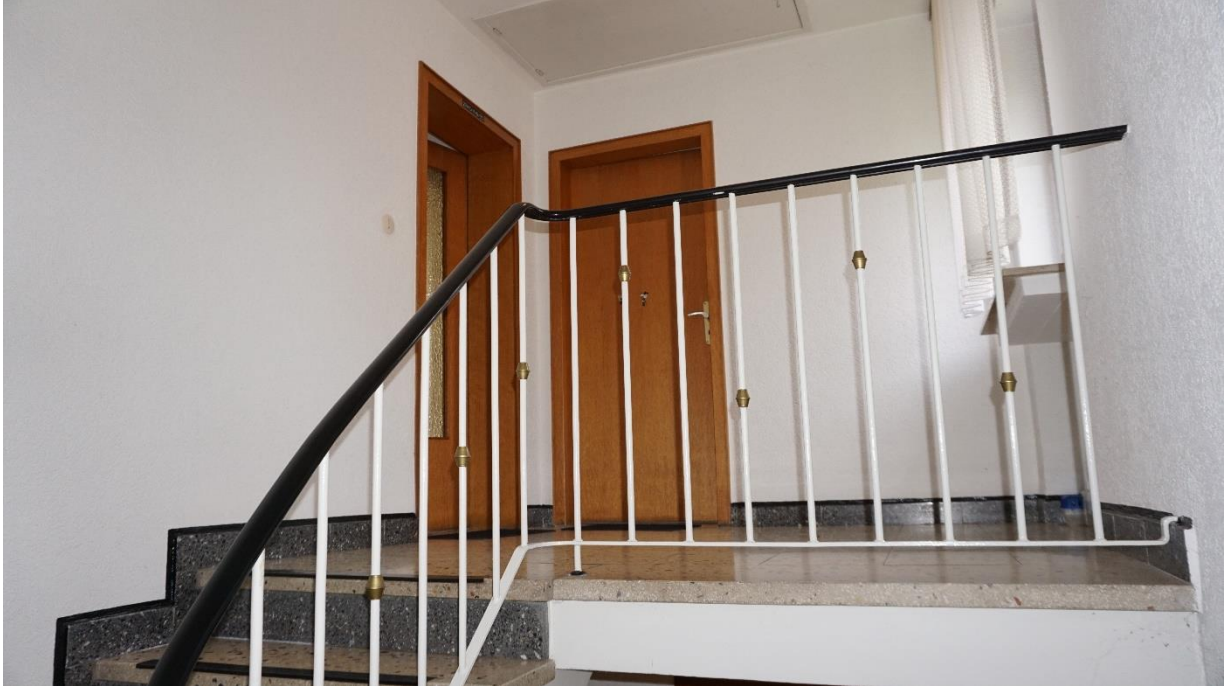
Treppenhaus mit Eingangstür zur Wohnung im Obergeschoss, Ansicht 01
