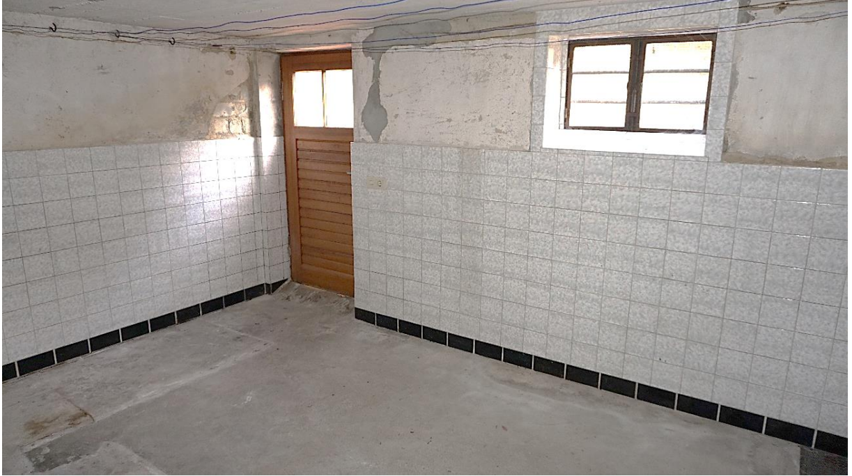
Waschküche mit Gartenausgang, Ansicht 01
