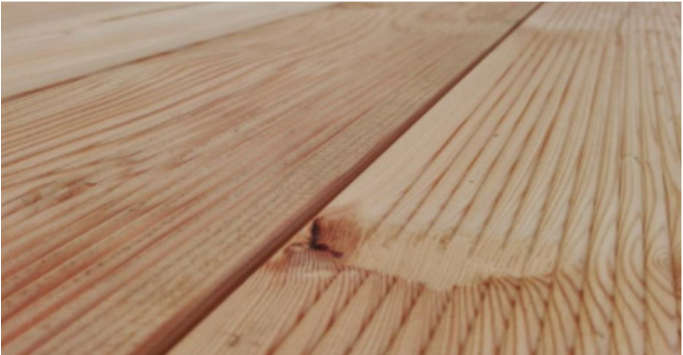
Foto 22 – ein gebrochener, abgesplitterter Ast
