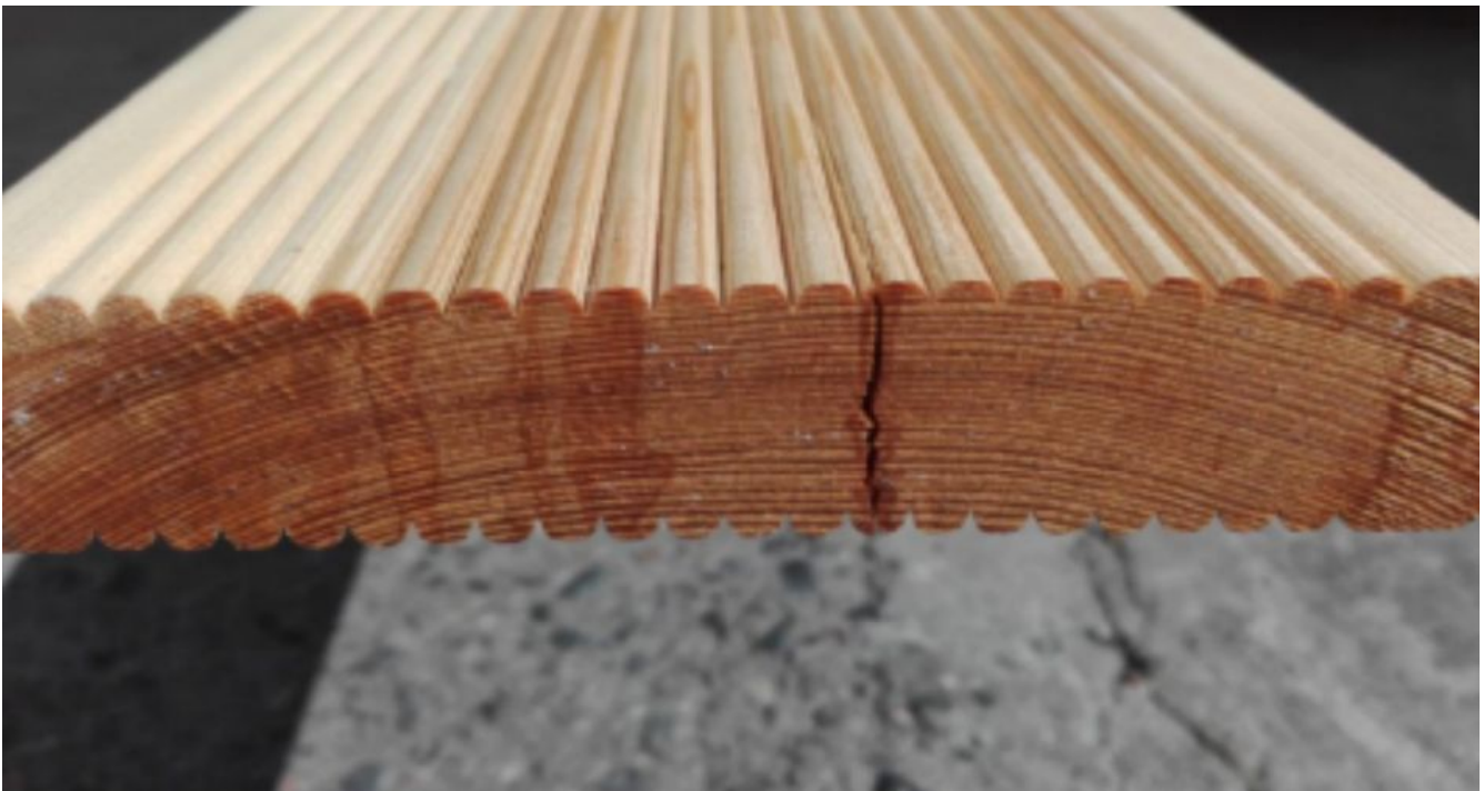
Foto 10 – ein frontal gelegener, durchlaufender Riss
