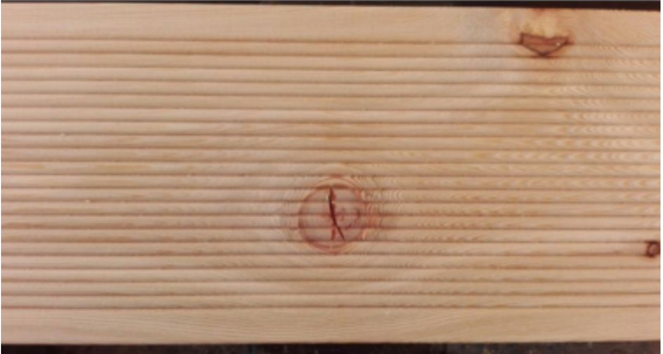
Foto 21 – ein aufgerissener, herausbröckelnder Ast
